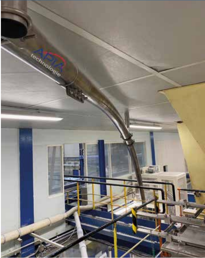
Vis flexible installée sur le site d'Artenay de Tereos.
