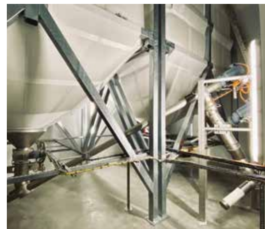
Les vis flexibles installées en reprise de silos souples alimentent le fondoir en automatique.
