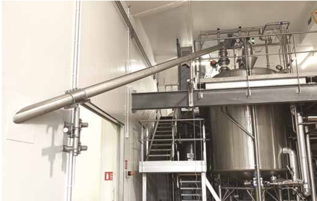
L'alimentation du fondoir est assurée automatiquement par vis flexible.
