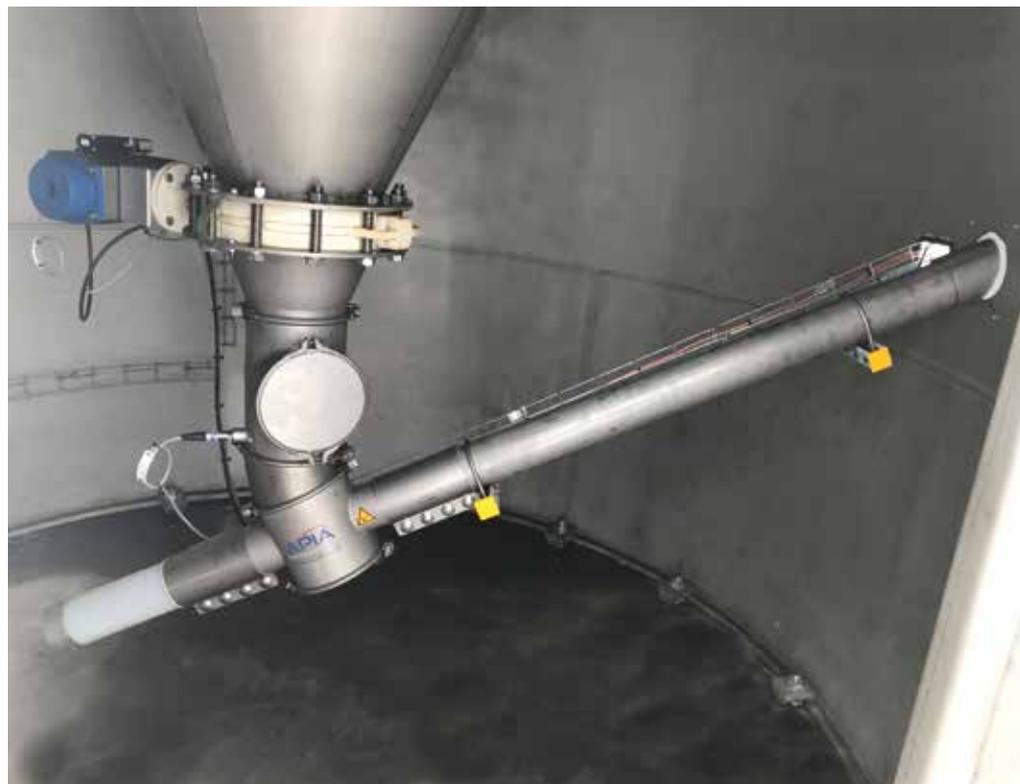
Reprise sous silo par vis flexible conforme ATEX.
